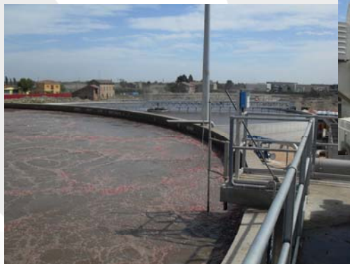
Impianto di depurazione. Sopra: unità di sgrigliatura Idrascreen™. A sinistra: ossidazione biologica
