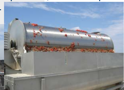
Impianto di depurazione. Sopra: unità di sgrigliatura Idrascreen™. A sinistra: ossidazione biologica
