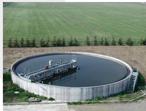
Vasca di decantazione
